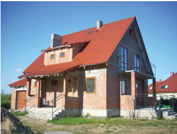
Rys. 1. Widok analizowanego domu (10.06.2009)
