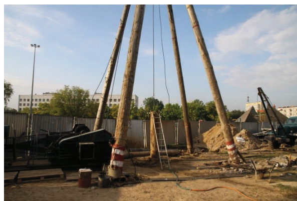
Rys. 5. Wykonywanie studni głębinowej zrzutowej.
