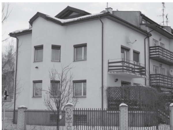
Rys. 1. Widok elewacji południowo-zachodniej (Wieczorkiewicz A., 2014)
