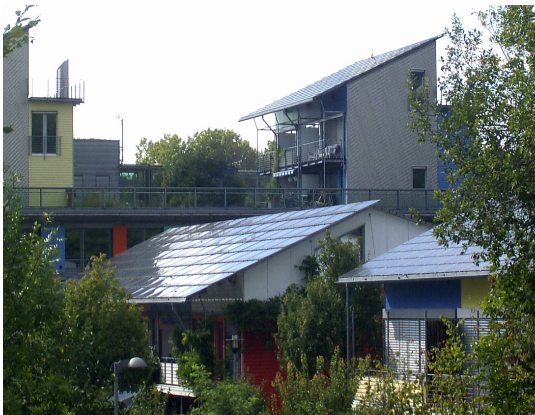
Rys. 3. Instalacje fotowoltaiczne zintegrowane z dachem budynku - widok ogólny, Freiburg (Niemcy)
