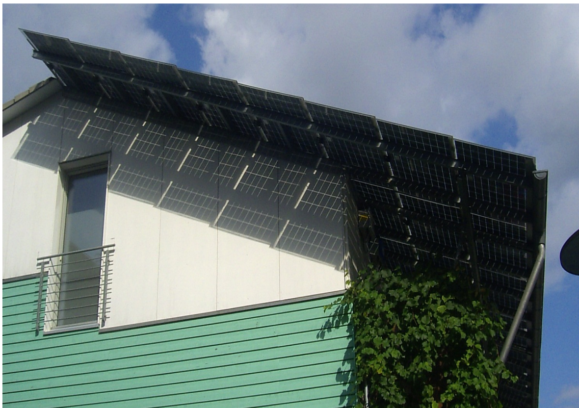
Rys. 4. Instalacja fotowoltaiczna zintegrowana z dachem budynku, Freiburg, Niemcy
