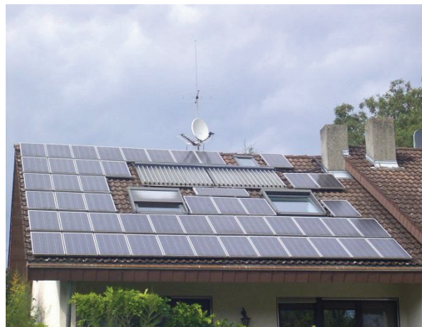
Rys. 1. Budynek wyposażony w instalację fotowoltaiczną oraz kolektory słoneczne (fot. J. Bigorajski)
