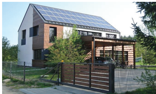
Rys. 1. Instalacja PV o mocy 9,75 kW p na dachu budynku, , fot. Przemysław Romaniuk
